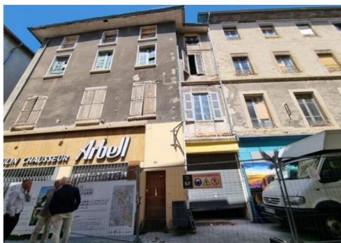
L'interstice entre les immeubles aux numéros 42 (à droite) et 44 sera reconstruit pour devenir une percée traversante; de nouveaux accès seront également créés. Photos Le DL/H.D.
