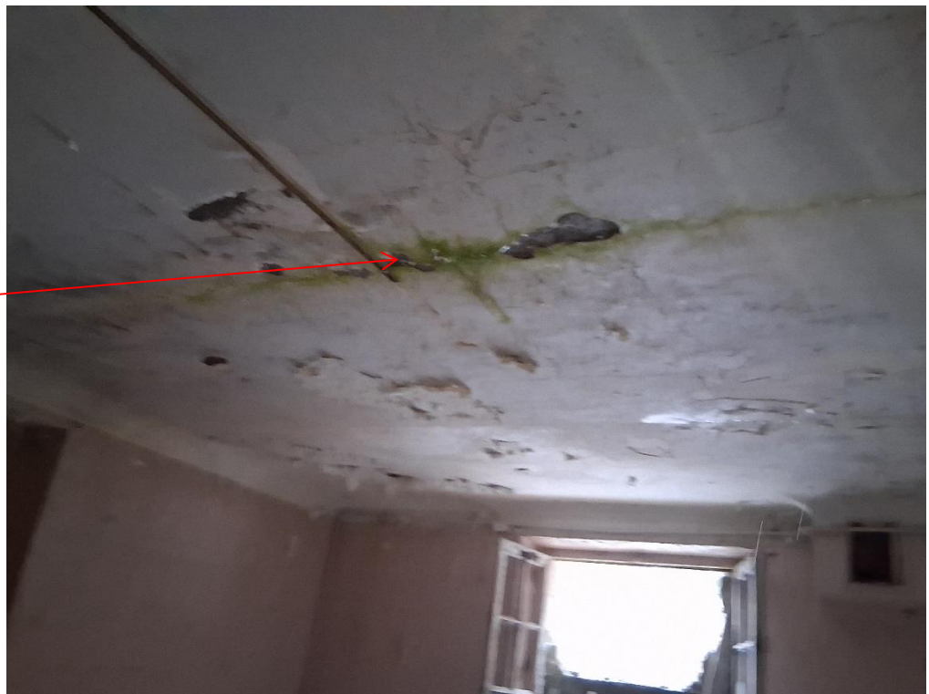
Fig. 18 – Fissure et trace d'infiltration
