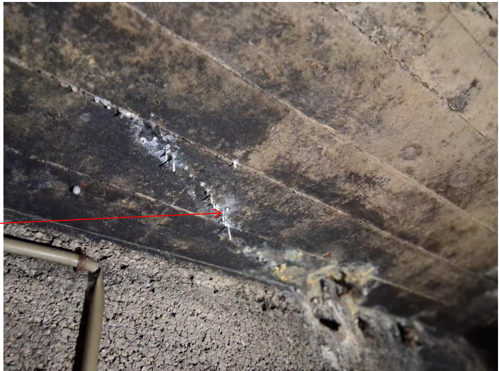
Fig. 5 – Fissure et stalactite
