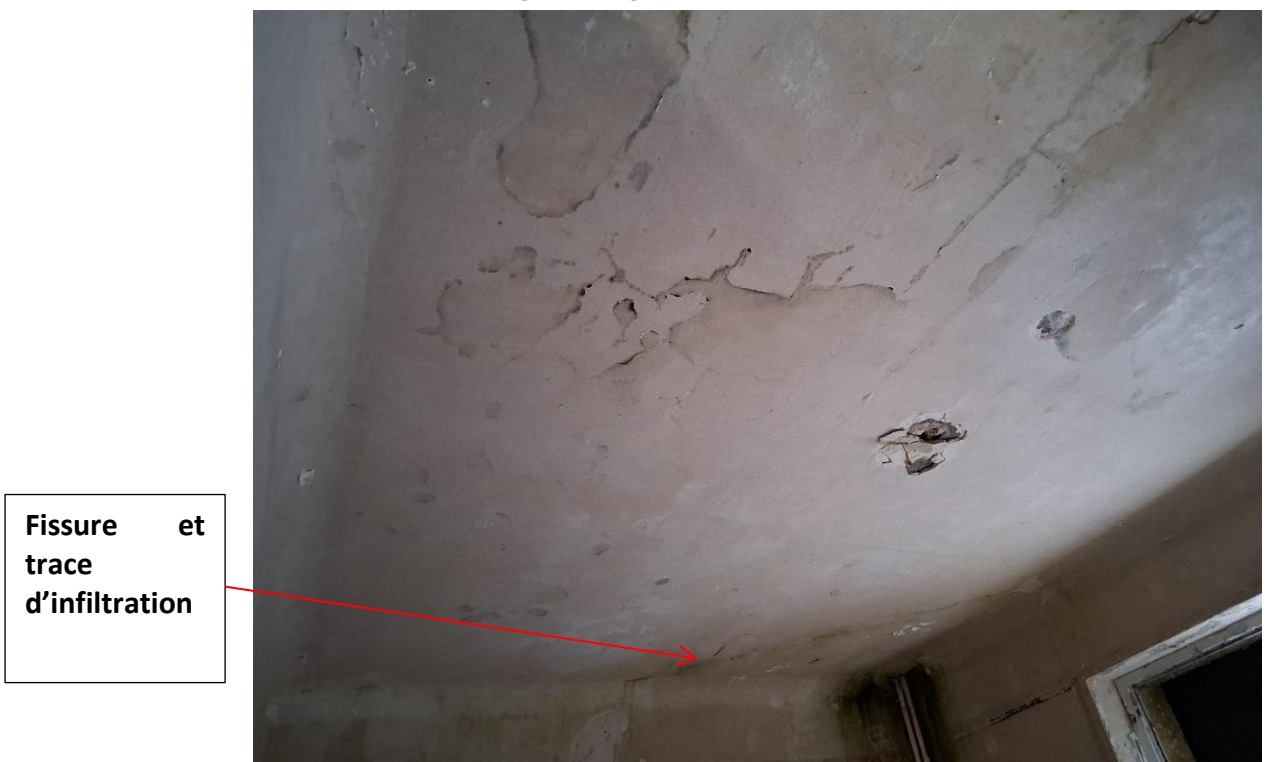
Fig. 8 – Fissure
