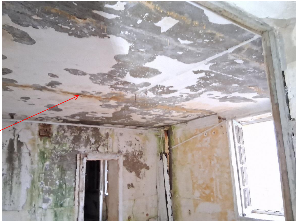
Fig. 17 – Fissure et stalactites
