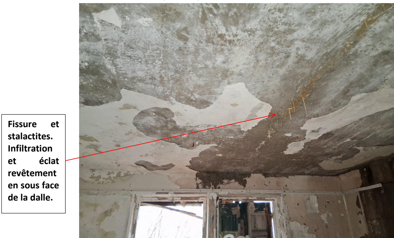
Fig. 10 – Fissure et stalactites
