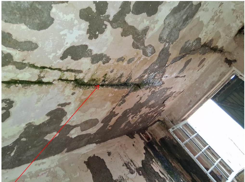
Fig. 13 – Flaque d'eau issue des infiltrations
