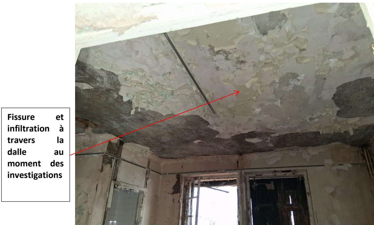
Fig. 12 – Fissure et infiltration
