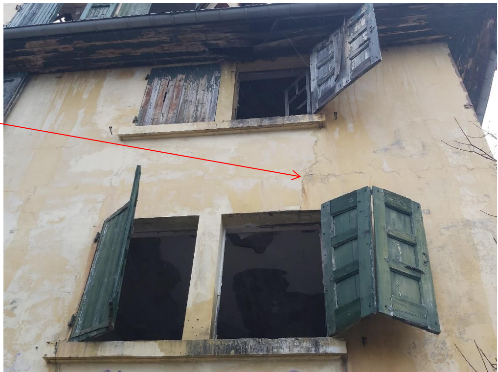
Fig. 21 – Fissures
