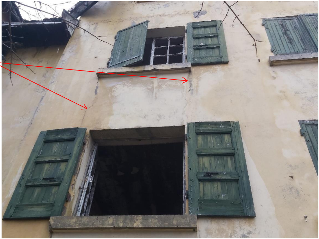
Fig. 19 – Fissures
