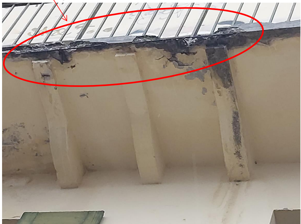
Fig. 23 – Eclat béton et corrosion aciers
