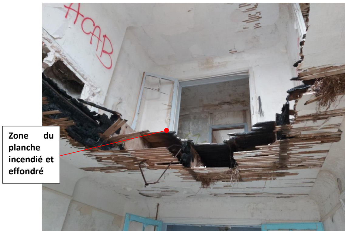
Fig. 8 – Zone d'effondrement – Plancher haut du RDC
