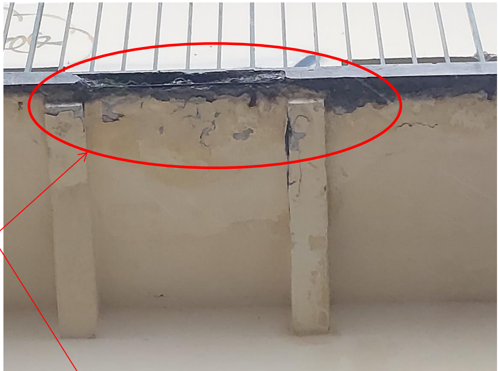
Fig. 22 – Eclat béton et corrosion aciers
