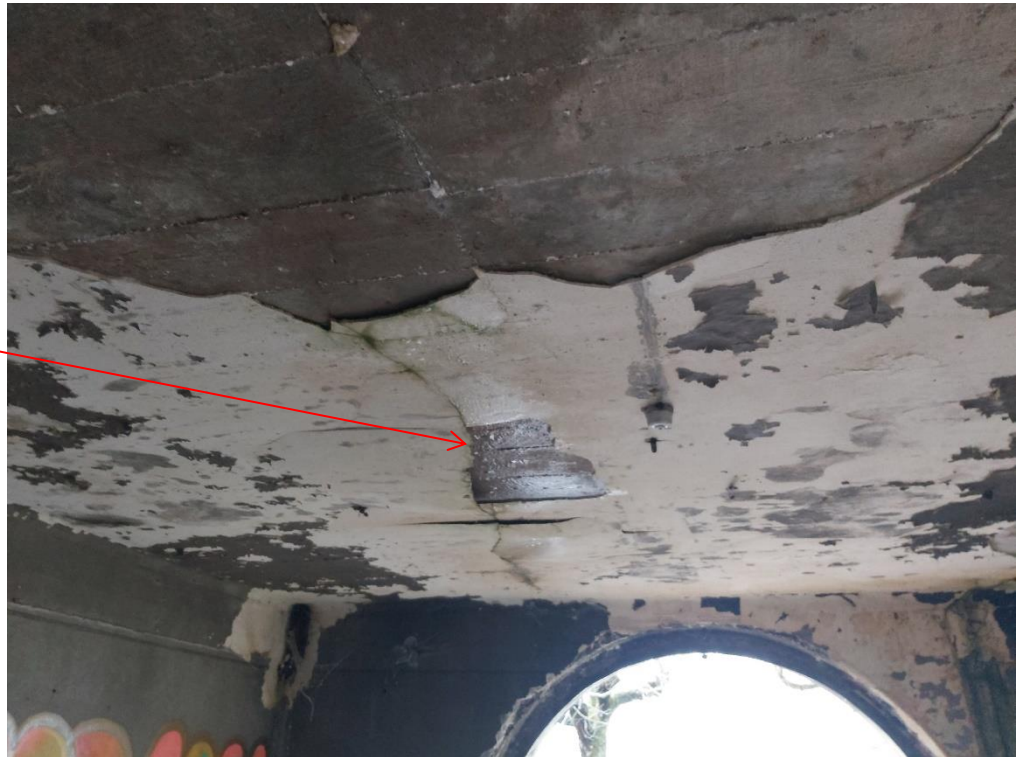
Fig. 38 – Fissure PH RDC
