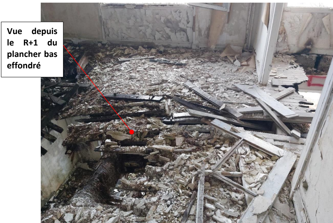
Fig. 9 – Zone d'effondrement – Plancher bas R+1
