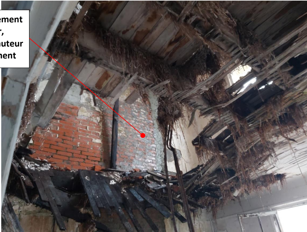
Fig. 12 – Zone d'effondrement
