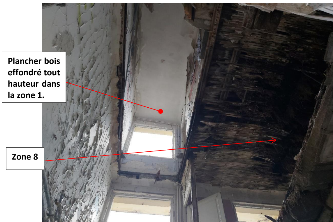
Fig. 14 – plancher effondré
