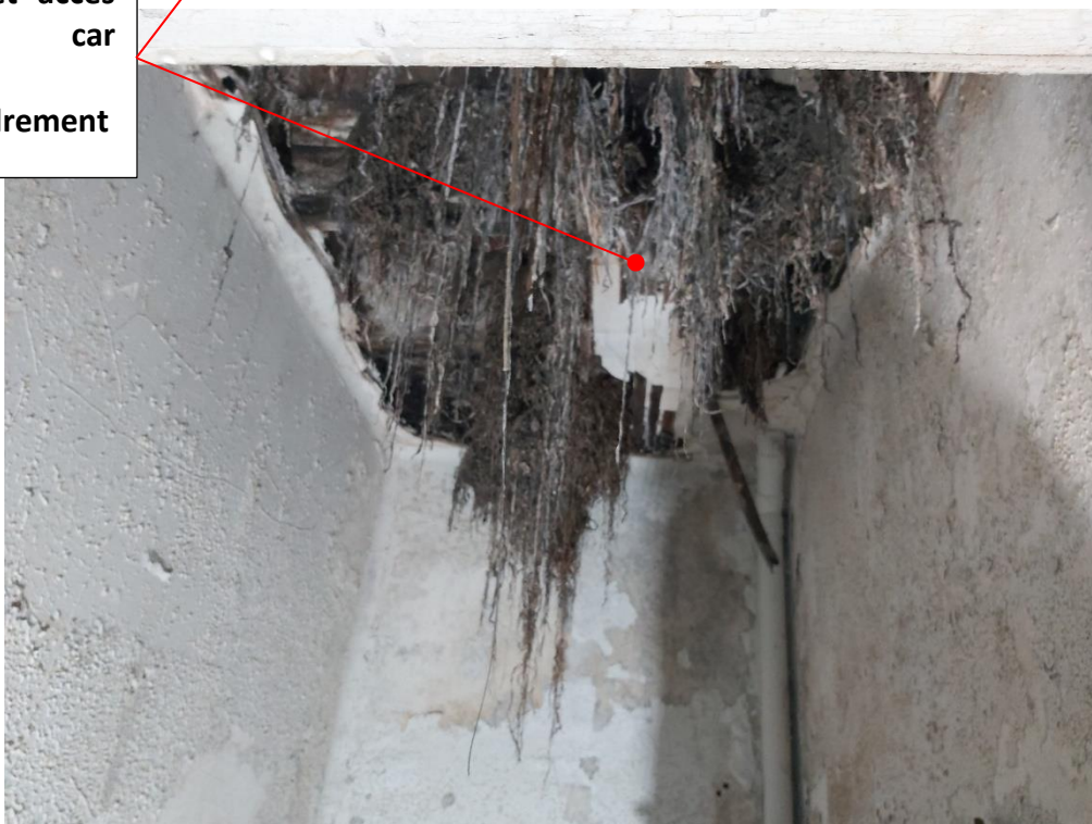
Fig. 11 – Plancher bois pourri – zone WC au bout du couloir
