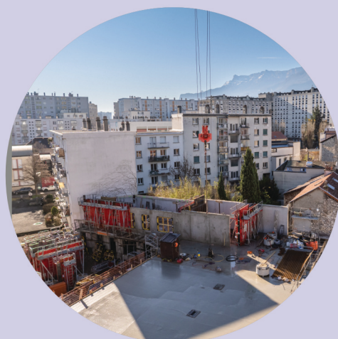
Futur siège de l'epfl du Dauphiné Lancement du chantier
