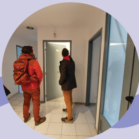
1er chantier de réhabilitation Cabinet médical à Varcès
